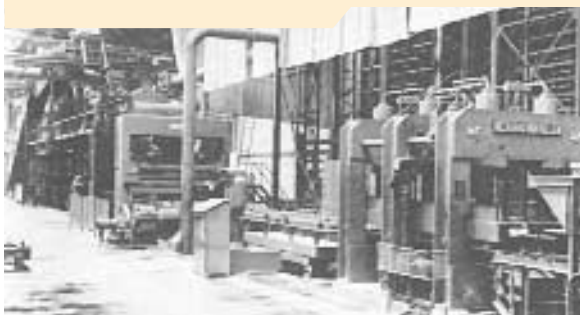
Θερμή μονή πρέσα τύπου Becker & van Hullen (1945)
