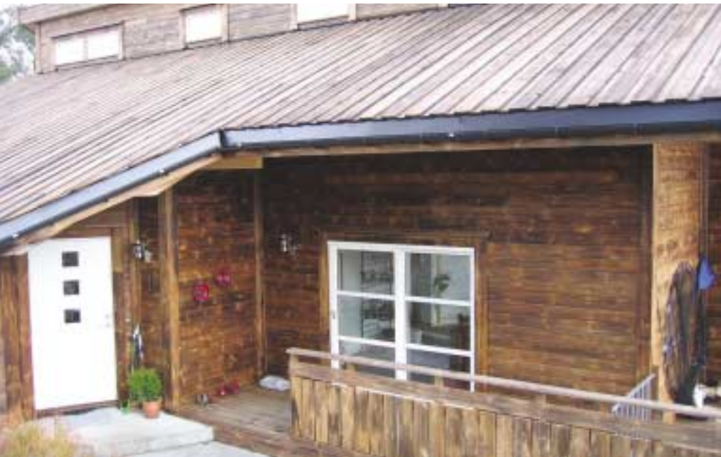
Οικία όπου η επένδυση των τοίχων, η στέγη και το decking είναι από Visorwood
