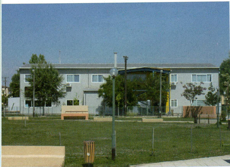
Το κτίριο εργαστηρίων του Τμήματος Σχεδιασμού και Τεχνολογίας Ξύλου και Επίπλου http://www.wfdt.teilar.gr/cd.php
