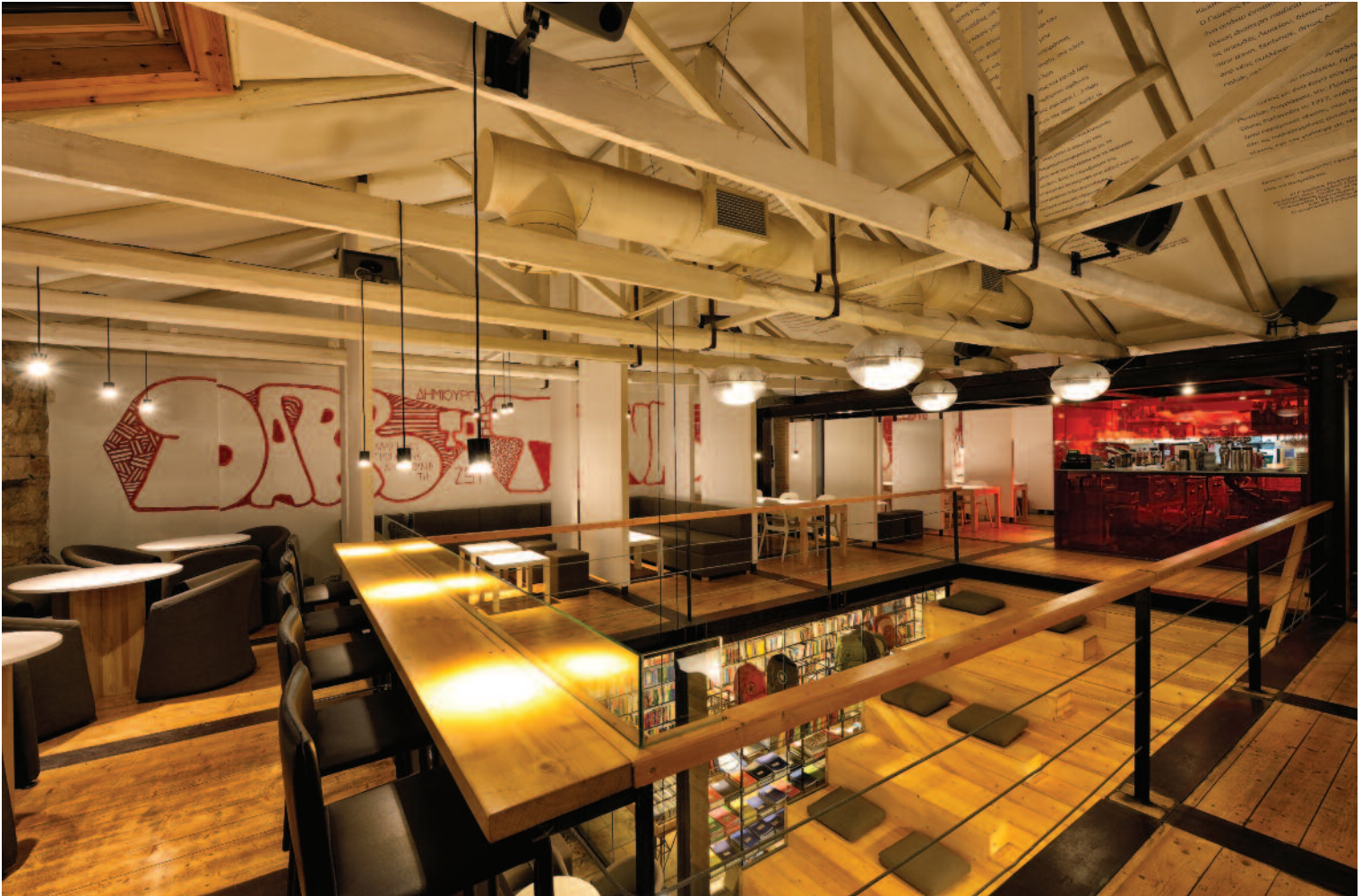
Ξύλινα ζευκτά στη στέγη βιβλιοπωλείο - αναγνωστηρίου στην Πάτρα, αρχιτεκτονική μελέτη: Μυρτώ Κιούρτη. © Νίκος Ψαθογιαννάκης
