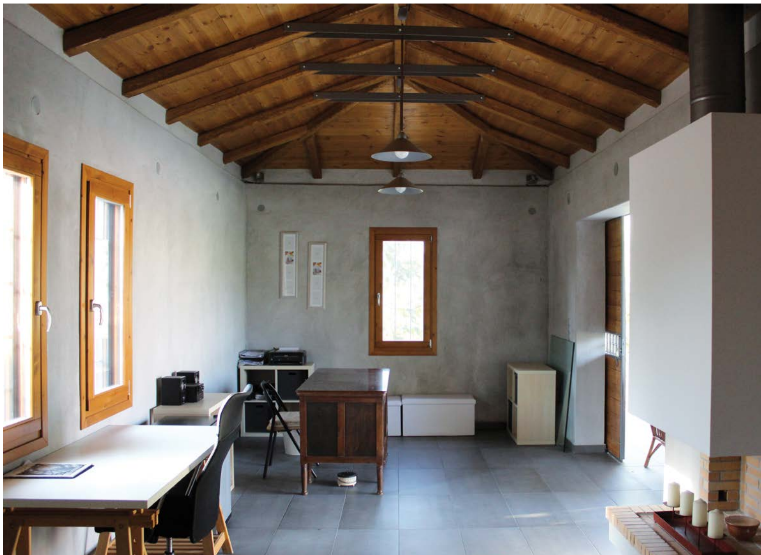
Στο εσωτερικό των κτιρίων τα ξύλινα στοιχεία, όπως είναι οι στέγες, τα πατώματα, τα κουφώματα κ.ά., θα πρέπει να ελέγχονται συστηματικά, ώστε να αποφευχθεί η πιθανή προσβολή τους από ξυλοφάγα έντομα. Κατοικία στο Πήλιο, αρχιτεκτονική μελέτη: Adamakis Architects & Associates. Φωτογραφία: Στέφανος Αδαμάκης.
