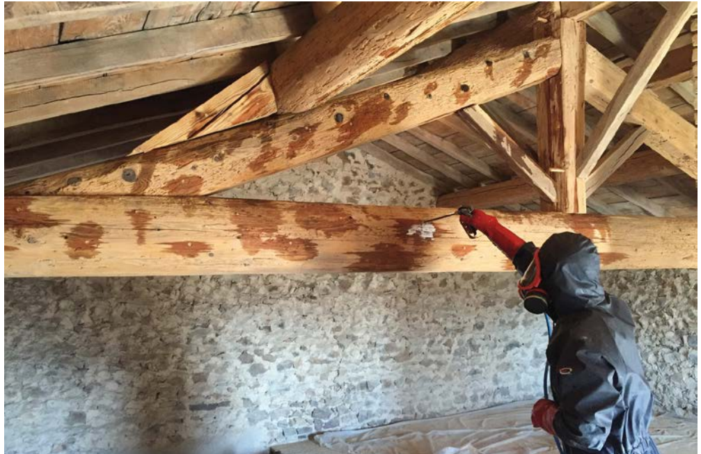
Οι μέθοδοι έγχυσης εντομοκτόνων ουσιών βρίσκουν εφαρμογή σε ένα ευρύ φάσμα αντικειμένων και οι χημικές ουσίες εισάγονται στο ξύλο σε υγρή μορφή με ειδικές συσκευές.
