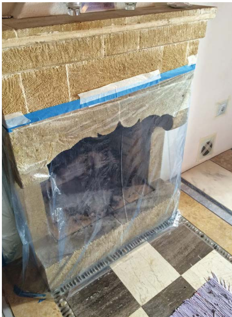
Σφράγιση εσωτερικού οικίας (τζακιού και εξώθυρας) με αεροστεγείς μεμβράνες για την εφαρμογή υποκαπνισμού.
