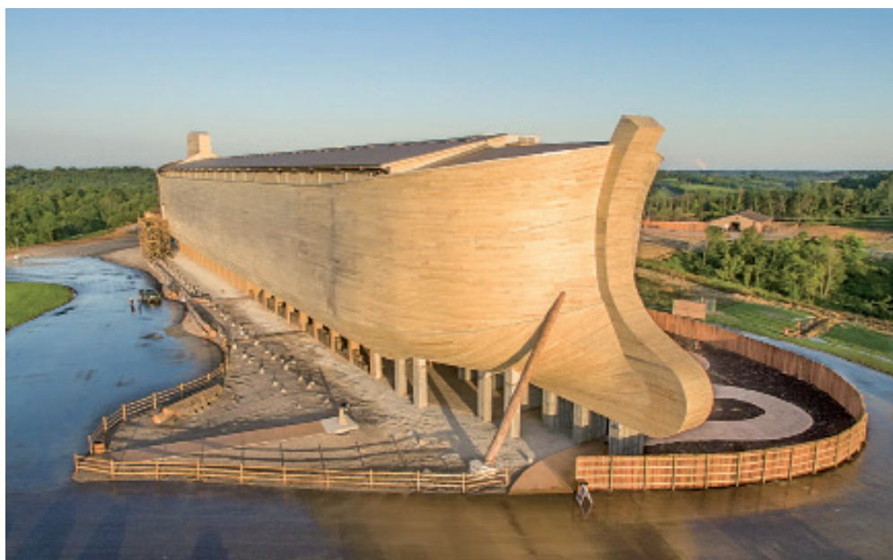
Η τεχνολογία της θερμικής τροποποίησης παράγει ξυλεία με αντοχή, υδροφοβία και βελτιωμένη βιολογική ανθεκτικότητα. Εφαρμογή της σε κέλυφος κτιρίου.
