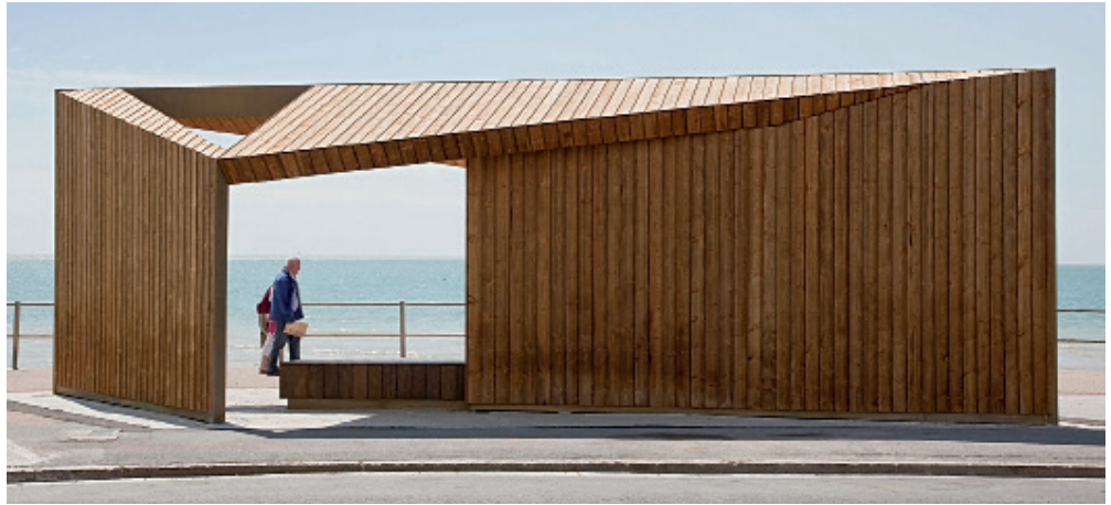
Η σκληρότητα και η αντοχή του ξύλου που έχει τροποποιηθεί με φουρφουρυλική αλκοόλη είναι μεγάλη, όπως πιστοποιείται από τη βιβλιογραφία και τα πειράματα που έχουν εκπονηθεί.
