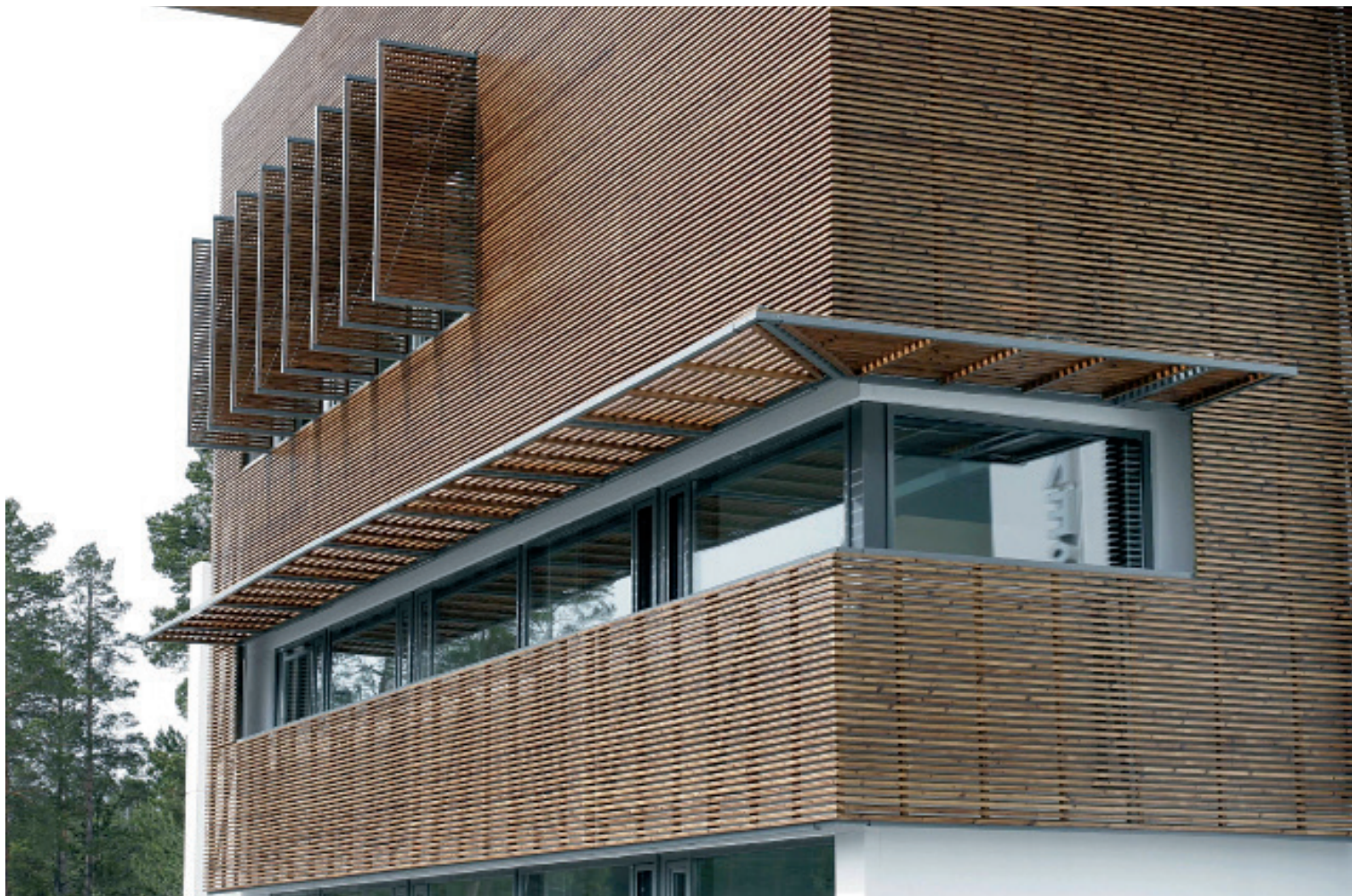
Η τεχνολογία της θερμικής τροποποίησης παράγει ξυλεία με αντοχή, υδροφοβία και βελτιωμένη βιολογική ανθεκτικότητα. Εφαρμογή της σε κέλυφος κτιρίου.
