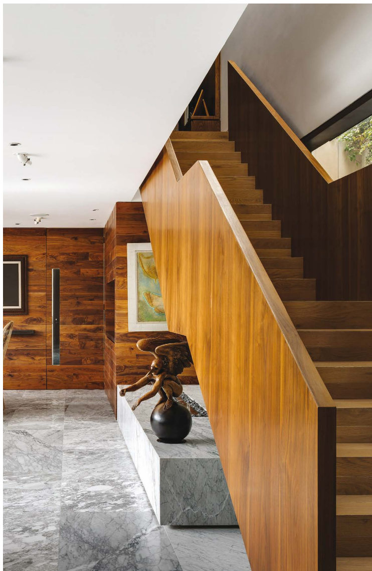
Ξύλινη εσωτερική σκάλα και στηθαίο, κατασκευασμένα από ένα είδος Mahogany (μαόνι Αφρικής).
