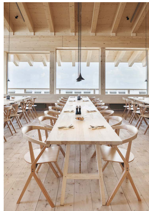
Προκατασκευασμένη κατασκευή από σύνθετη ζυλεία (glulam) ερυθρελάτης, πάτωμα από δασικό πεύκο και έπιπλα (τραπεζία και καρέκλες) από σφενδάμι, στο εστιατόριο Gipfelrestaurant στην Ελβετία, το οποίο σχεδιάστηκε από τους Herzog & de Meuron. © Juergen Pollak.
