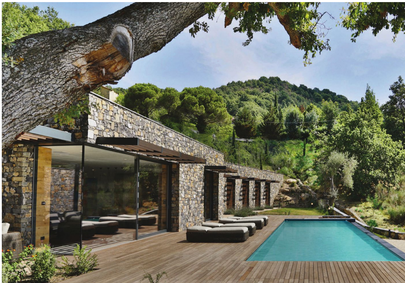
Εξωτερικό δάπεδο πολύ υψηλής ποιότητας από ξυλεία teak με χαρακτηριστικό σκοτεινό χρυσο-καφέ χρώμα. Η εξαιρετικά υψηλή του ανθεκτικότητα κάνει το teak να θεωρείται ο "βασιλιάς" των εξωτερικών δαπέδων.
