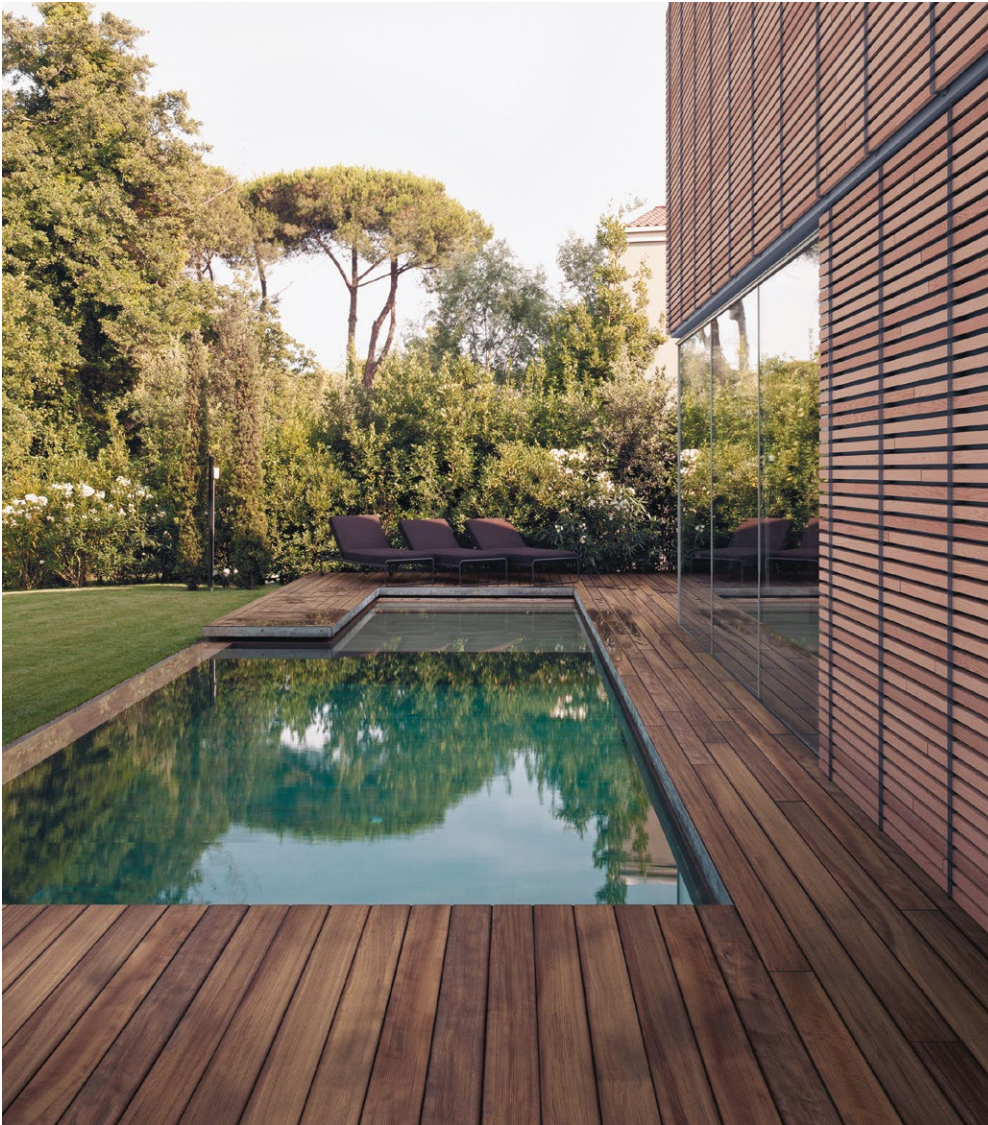
Δάπεδο τύπου deck, από ξυλεία Ιπέ, δίπλα σε πισίνα. Ως είδος ανήκει στα ironwoods, είναι ιδιαίτερα ανθεκτικό στη φθορά και στους βιολογικούς εχθρούς και θεωρείται άκαυστο. Είναι όμως πολύ δυσκολοδούλευτο είδος.
