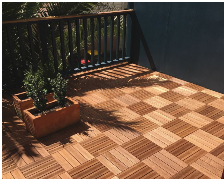
Στα δάπεδα με μορφή πλακών (deck tiles) τα μικρού μήκους στοιχεία είναι προσαρμοσμένα σε μια βάση πλέγματος. Συστήνεται η διαβροχή της επιφάνειάς τους, ώστε να μην παραμορφώνονται και ξεκολλούν από τη βάση.
