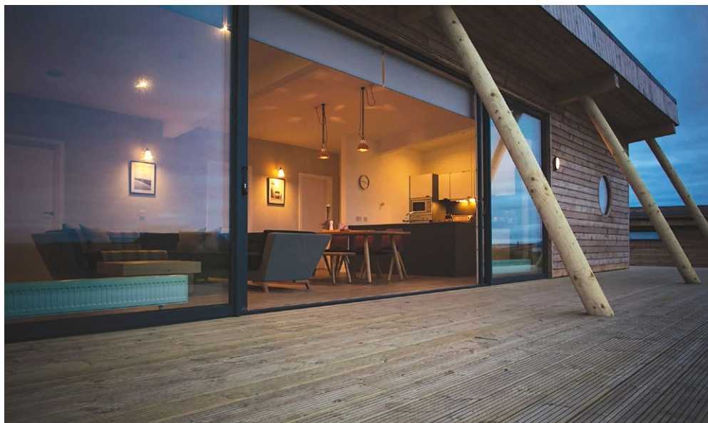
Τα εξωτερικά δάπεδα διατίθενται σε μεγάλα μήκη (>1 m) και πλάτη >9 cm. Το πάχος τους κυμαίνεται μεταξύ 20 - 25 mm και κατά μήκος της επιφάνειά τους είναι δυνατόν να φέρουν αντιολισθητικές ραβδώσεις.
