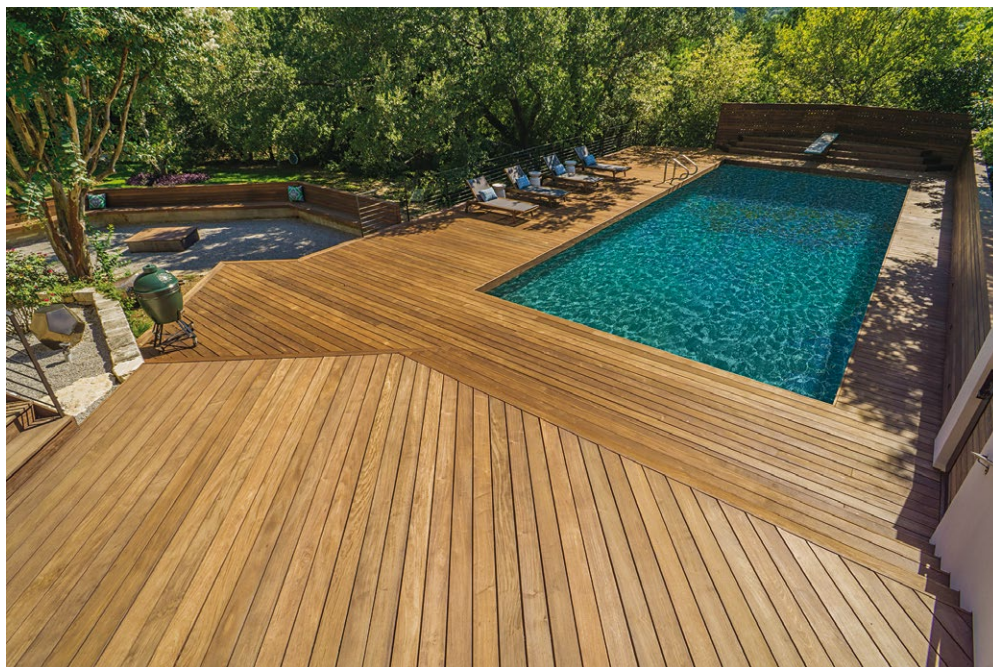
Η ξυλεία Kebony παράγεται με ακίνδυνη χημική τροποποίηση του ξύλου, η οποία προσφέρει μεγάλη σκληρότητα και αντοχή.
