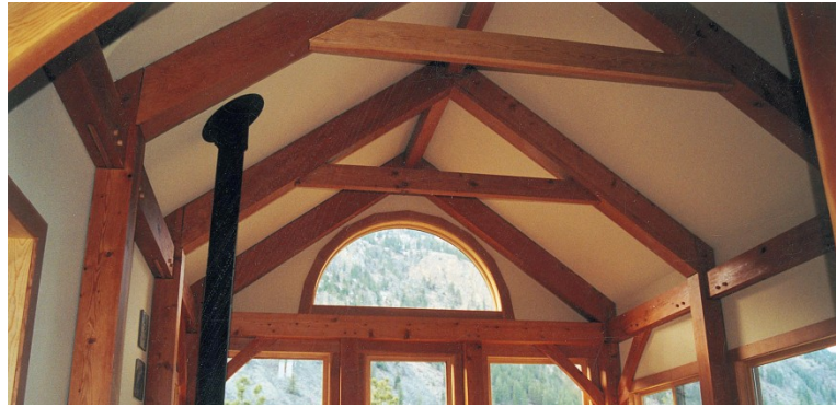
Σχήμα 1.2. Φέροντα στοιχεία ξύλου σε στέγη.
