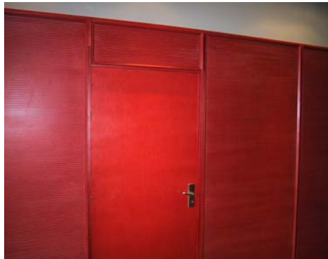
Εικόνα 3. Κούφωμα κατασκευασμένο από χρωματιστό MDF Photo 3. Door made from coloured MDF
