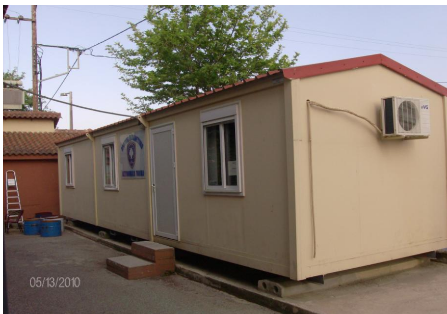
Εικόνα 2. Η μια προκάτ κατασκευή της Σχολής Αστυφυλάκων Καρδίτσας
