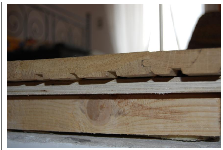
Φωτ. 1. Τρόπος τοποθέτησης του δρύινου παρκέτου.
