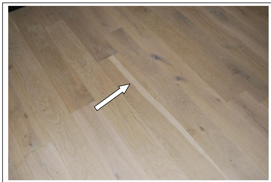
Φωτ. 4. Εμφάνιση έντονων διχρωμιών και παρουσία σομόφου ξύλου.
