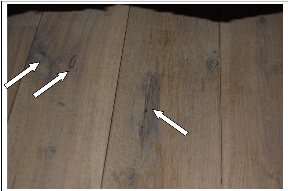
Φωτ.2. Εμφάνιση ρόζων και ραγάδων.
