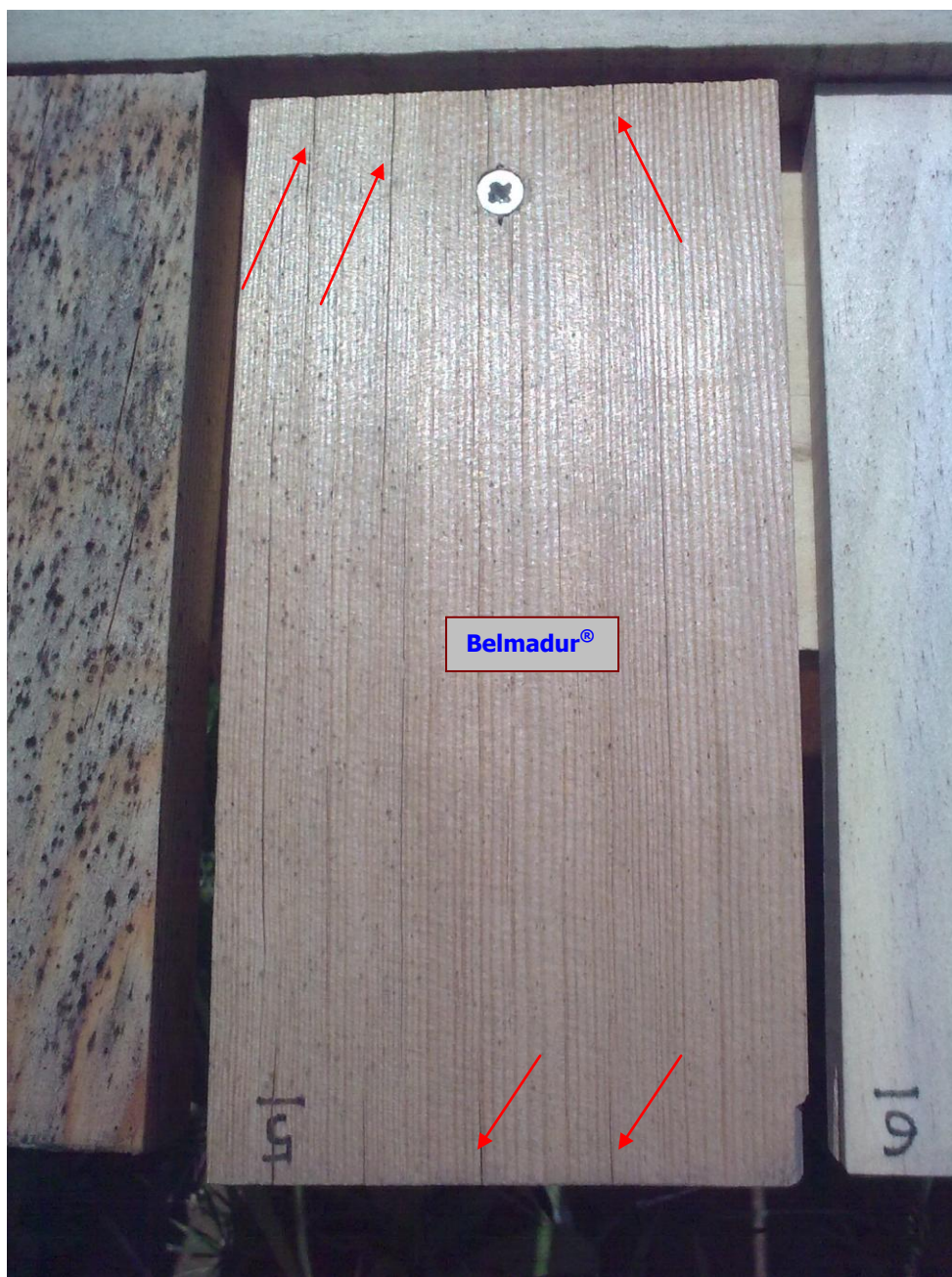
Εικ. 4: Εξωτερική εμφάνιση του Belmadur την 18-Απρ-2011 (βλ. βέλη = μικρές ραγαδώσεις)
