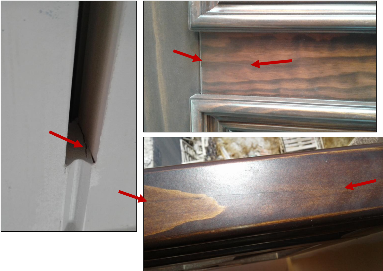
Εικ. 2, 3, 4. Ξύλινα στοιχεία κατασκευών με ενδεικτικά σχισίματα / 'ανοίγματα'
