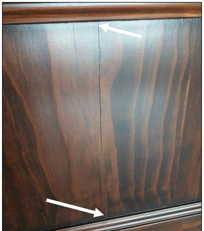
Εικ. 5, 6, 7. Τα επιμήκη σχισίματα στους νταμπλάδες του ξύλινου κουφώματος.
