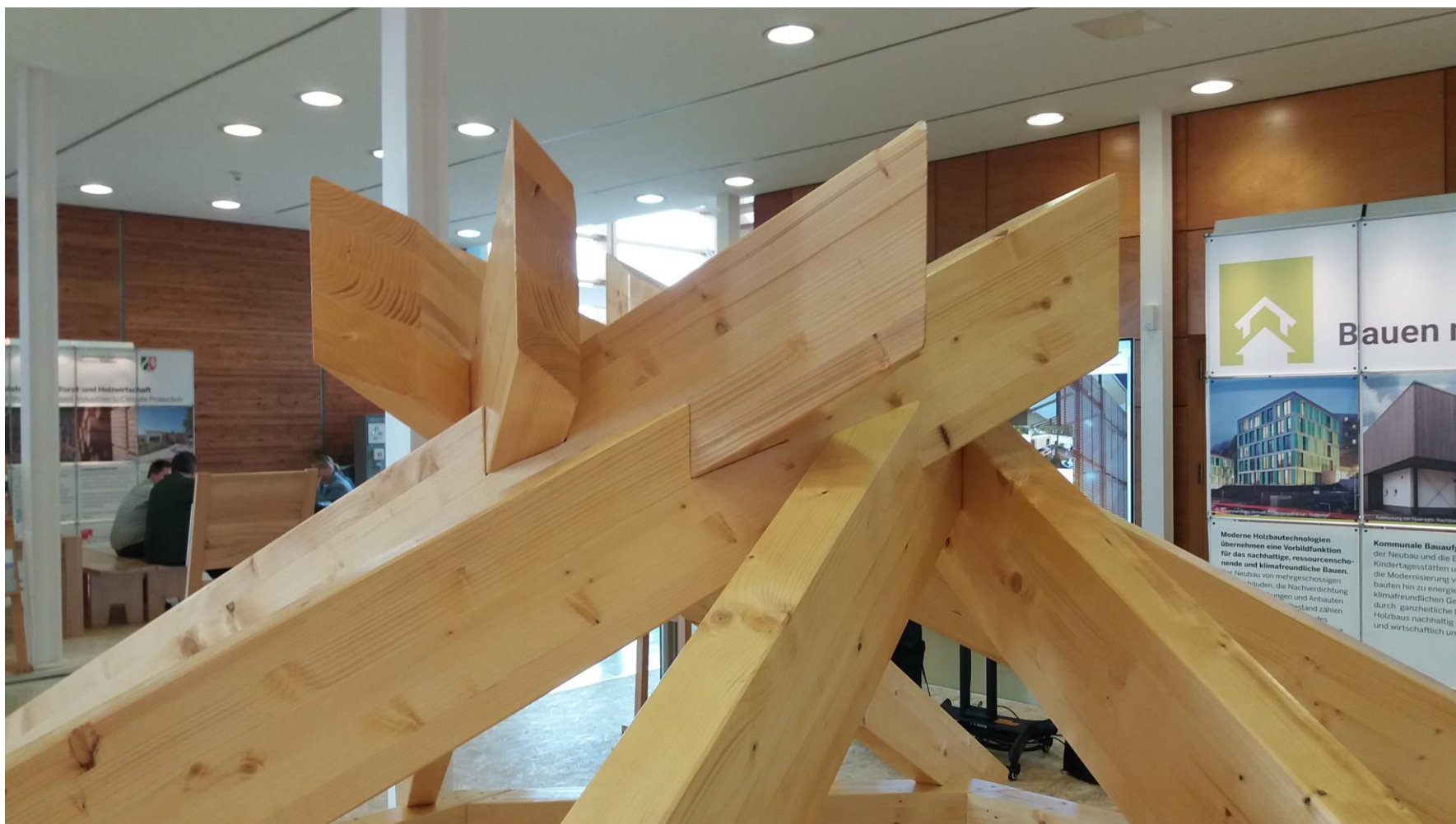
Παραδοσιακή γερμανική συνδεσμολογία ξύλινων στοιχείων σε στέγη.
