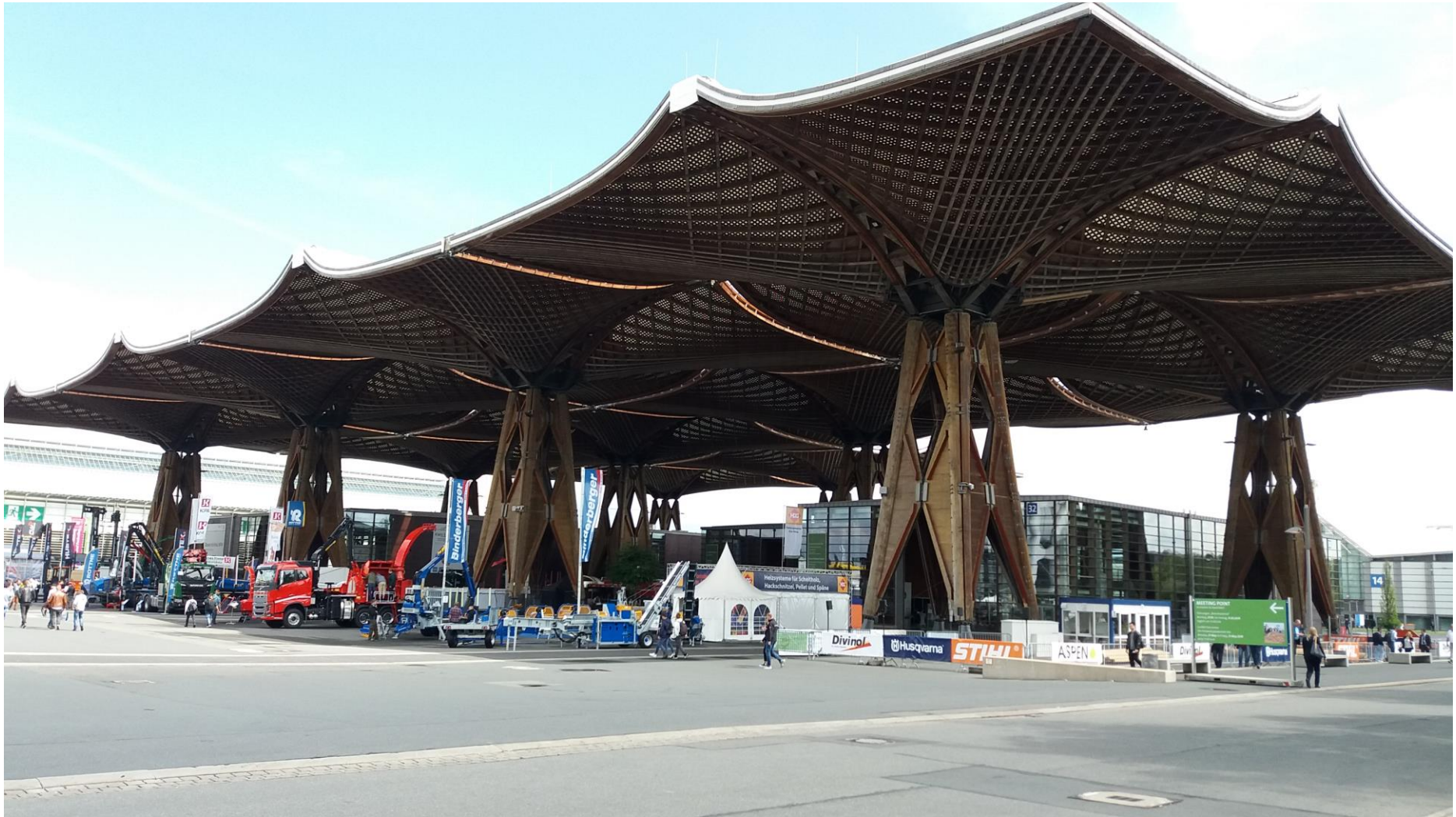
Η εντυπωσιακή μεικτή κατασκευή χάλυβα-ξύλου (στέγαστρο) της εν λόγω έκθεσης.
