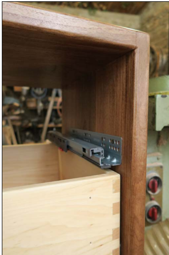
Εικόνα 164α. Τοποθέτηση σιδηροδρόμων (Φωτ. Προσωπικό αρχείο).
