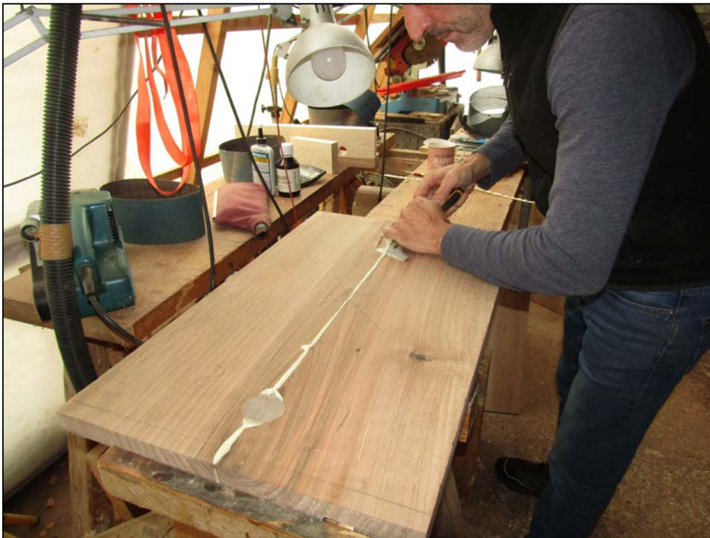
Εικόνα 108. Αφαίρεση της περίσσειας κόλλας (Φωτ. Προσωπικό αρχείο).
