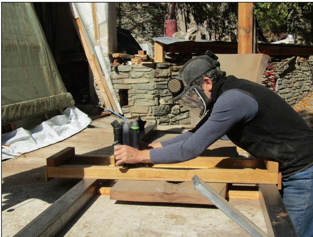
Εικόνα 35. Εφαρμογή του ρούτερ στην βάση (Φωτ. Προσωπικό αρχείο).
