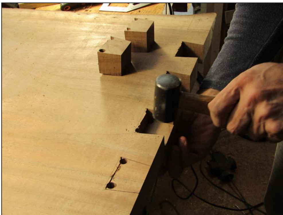
Εικόνα 81. Αφαίρεση κομμένων τμημάτων (Φωτ. Προσωπικό αρχείο).
