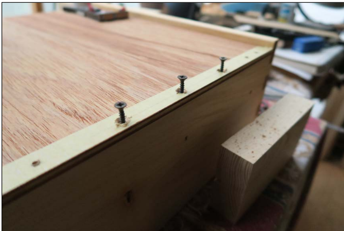
Εικόνα 151β. Τοποθέτηση πατωμάτων στα συρτάρια (Φωτ. Προσωπικό αρχείο).
