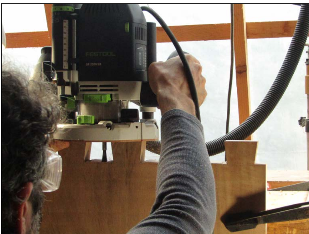
Εικόνα 82. Καθαρισμός βάσεων με ρούτερ (Φωτ. Προσωπικό αρχείο).
