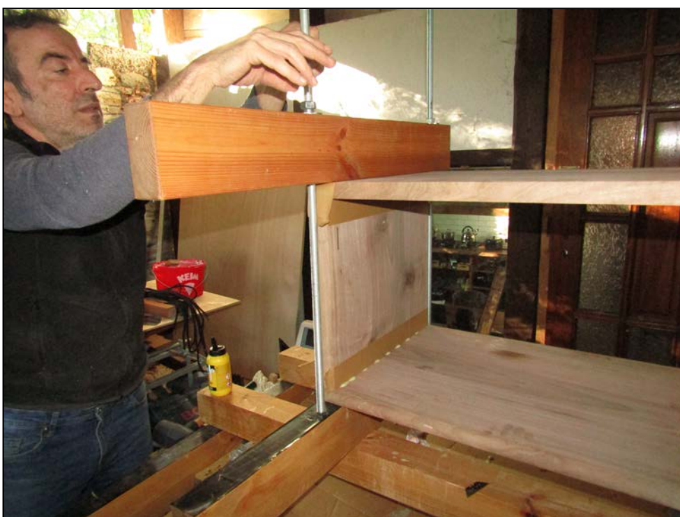
Εικόνα 66β. Σύσφιξη με μεταλλικές νίτζες (Φωτ. Προσωπικό αρχείο).
