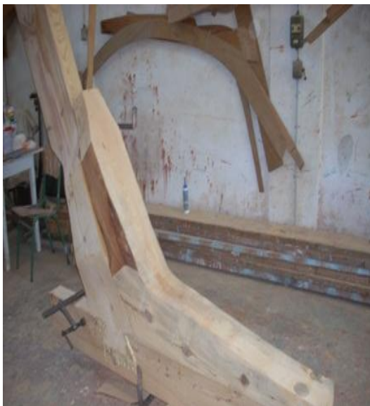
Εικ. 6.5.32: Τοποθέτηση σκορπιού στο πρυμίο ποδόσταμο. Είναι ξεκάθαρη η μορφή του ανάποδου Γ.
