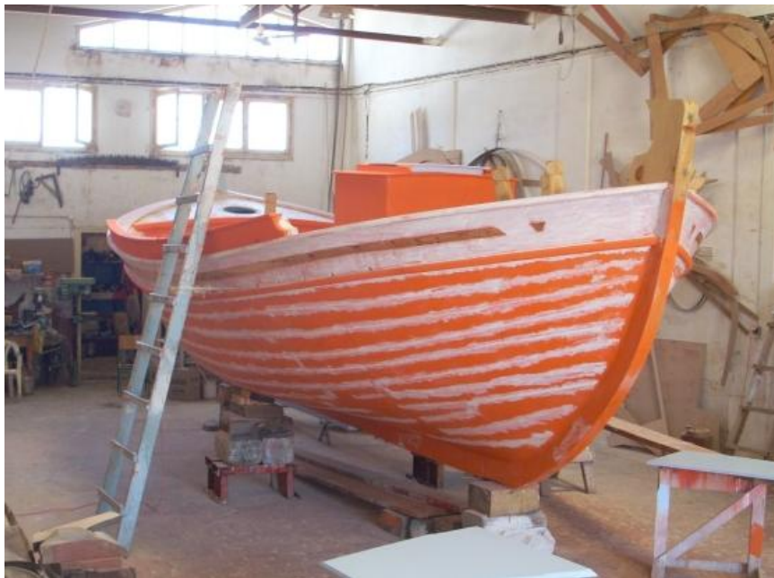
Εικόνα 6.250: Το τρεχαντήρι μετά την ολοκλήρωση της διαδικασίας του καλαφατίσματος και την τοποθέτηση στόκου σε όλα τα απαραίτητα σημεία. Το πλοiάριο είναι έτοιμο για να χαραχθεί πάνω του η γραμμή της ισάλου.
