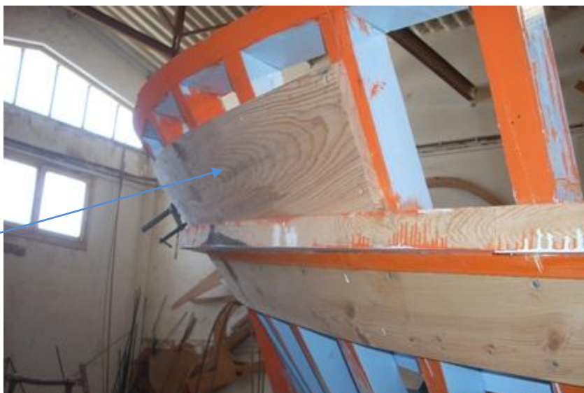
Εικόνα 6.179: Ο μπούρδος καρφώνεται πάνω στους νομείς.
