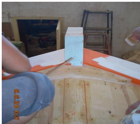
Εικόνα 6.259: Πρώτο χέρι χρώματος στην κουπαστή και την πρύμη του τρεχαντηριού.
