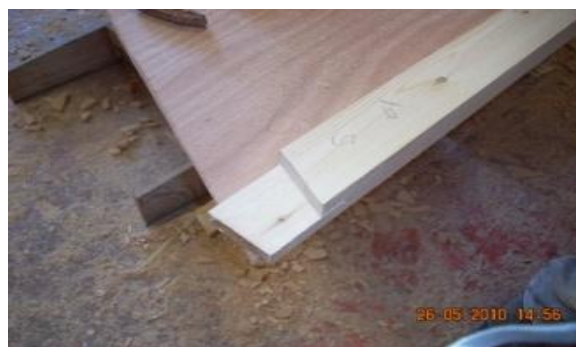
Εικόνα 6.221: Λεπτομέρεια σύνδεσης ορθοστατών γέφυρας.
