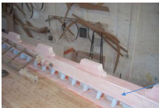
Εικόνα 6.180: Το δεύτερο αστάρι του σκάφους βρίσκεται κάτω από την κουπαστή.
