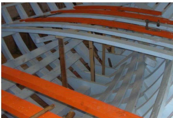
Εικόνα 6.157: Τη θέση του κενού στο κατάστρωμα θα πάρουν τα κουβούσια και τα κοντοκάμαρα.
