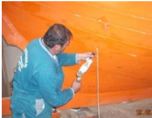
Εικόνα 6.241: Τοποθέτηση φυτιλιού στους αρμούς των σανιδιών. Το εργαλείο που κρατά στο δεξί του χέρι ο καλαφάτης ονομάζεται ματσόλα ή ζυλόσφυρο.
