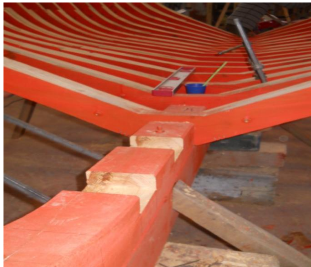
Εικ. 6.5.77: Στην εικόνα διακρίνονται οι εγκοπές στο ακράπι, όπου θα τοποθετηθούν τα ριπίδια.
