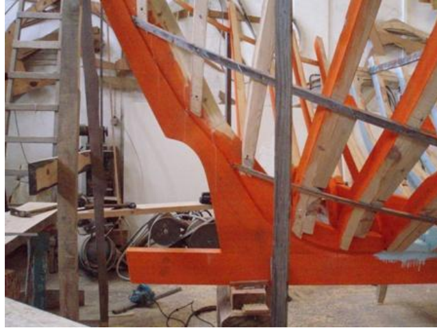
Εικ. 6.5.76: Οι φούρμες, ξύλινοι πήχεις, καρφώνονται στην εξωτερική πλευρά των νομέων και τα άκρα τους στηρίζονται στον ασό των ποδοσταμάτων.
