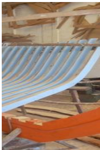
Εικ. 6.5.64: Τοποθέτηση μεσαίων νομέων.
