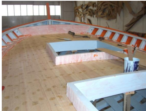
Εικόνα 6.184: Το πέτσωμα του καταστρώματος αποτελούν σανίδια πεύκου Μυτιλήνης, τοποθετημένα κάθετα στους νομείς του καϊκιού.
