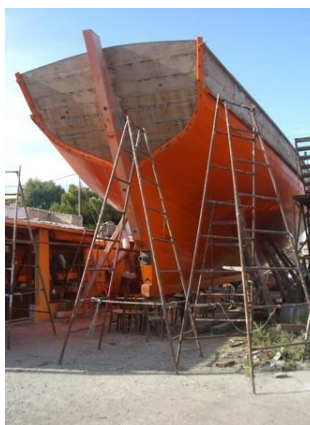
Εικ. 5.6.1.2: Συμακή σκάφη υπό κατασκευή με την μέθοδο της σάλας.
