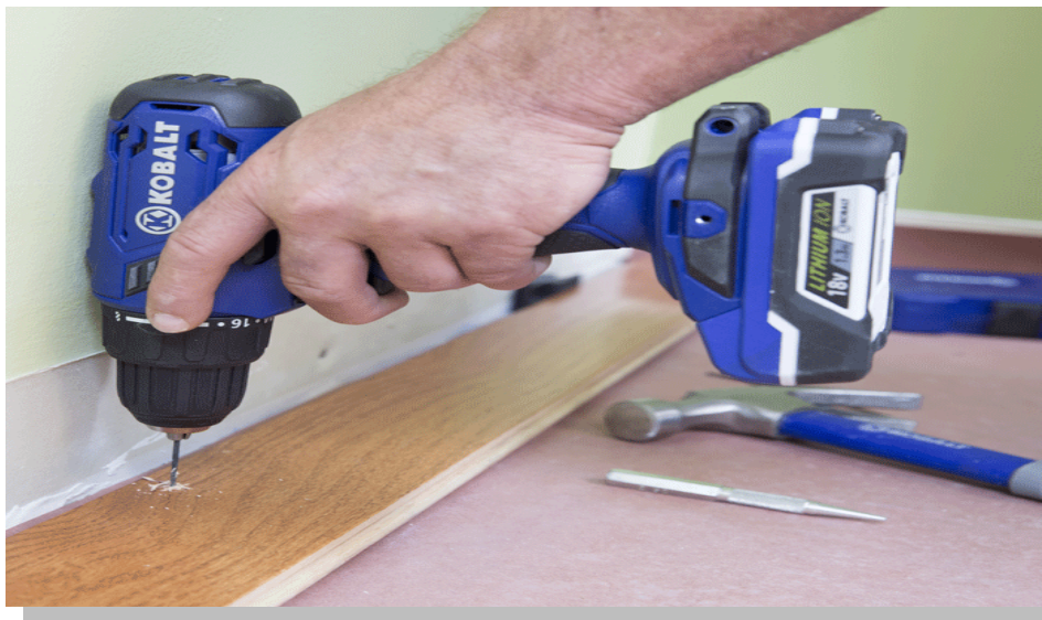
Εικόνα 3.33: Κατακόρυφο κάρφωμα της πρώτης σειράς
