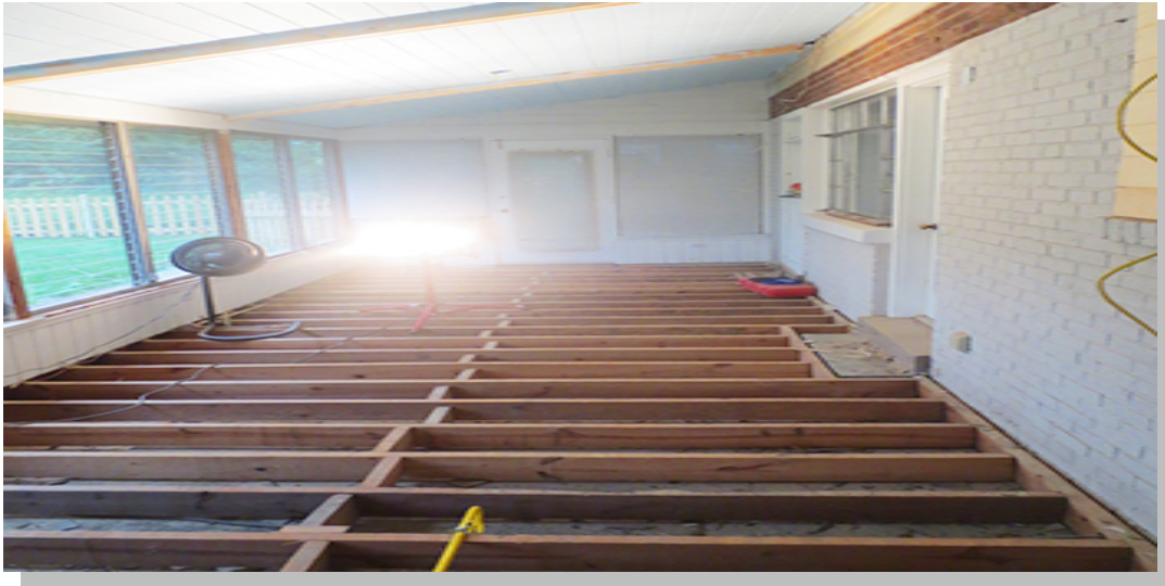
Εικόνα 3.29: Υπόστρωμα πλαισίου ξύλινων δοκών
