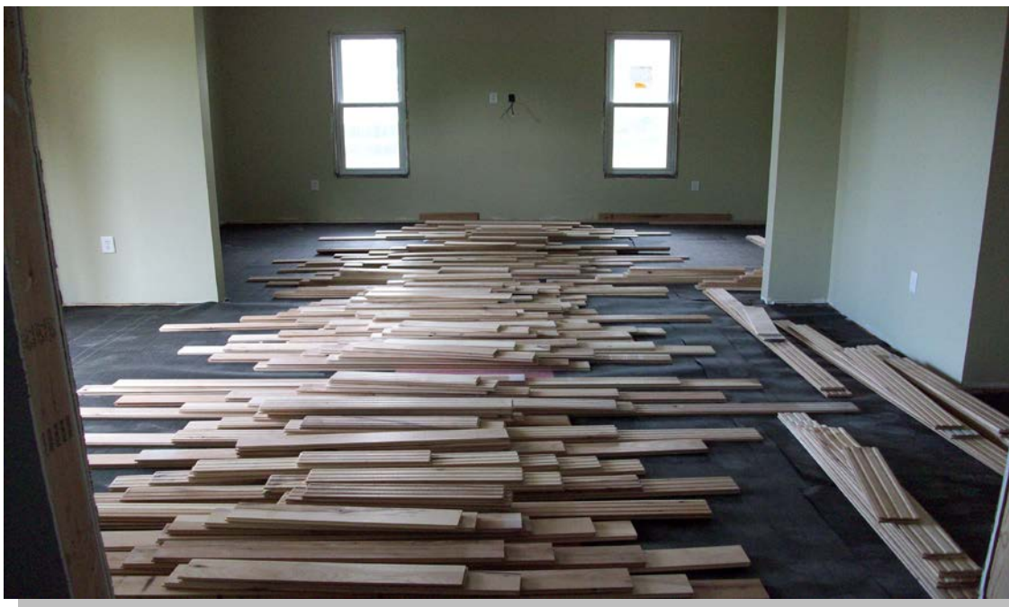
Εικόνα 3.25: Ισορροπία της υγρασίας του παρκέ με τις συνθήκες του περιβάλλοντος εγκατάστασής του
