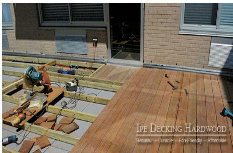
Εικόνα 3.40: Τοποθέτηση του κύριου δαπέδου κάθετα προς τη φορά των δοκών του υποστρώματος
