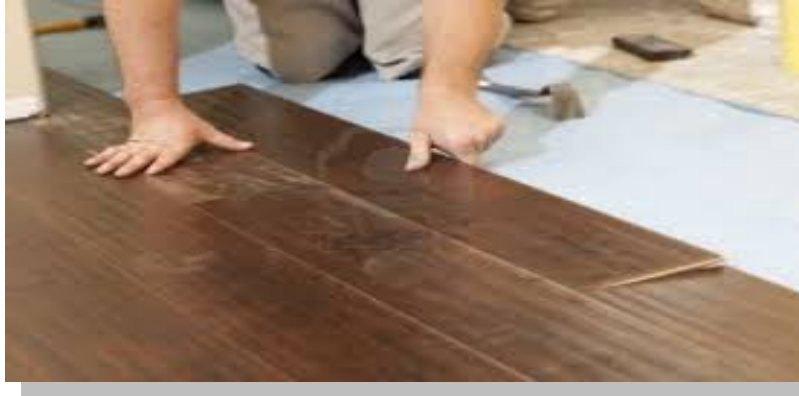
Εικόνα 3.21: Τοποθέτηση δαπέδου laminate
