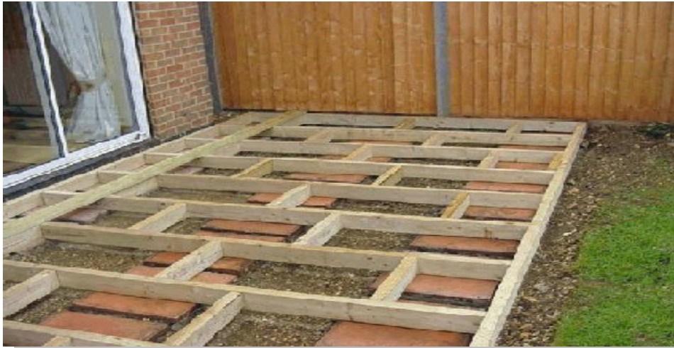
Εικόνα 3.38: Υπόστρωμα τοποθετημένο πάνω σε πλάκες τσιμέντου
