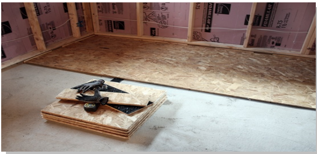
Εικόνα 3.28: Υπόστρωμα πλακών OSB πάνω σε τσιμέντο
