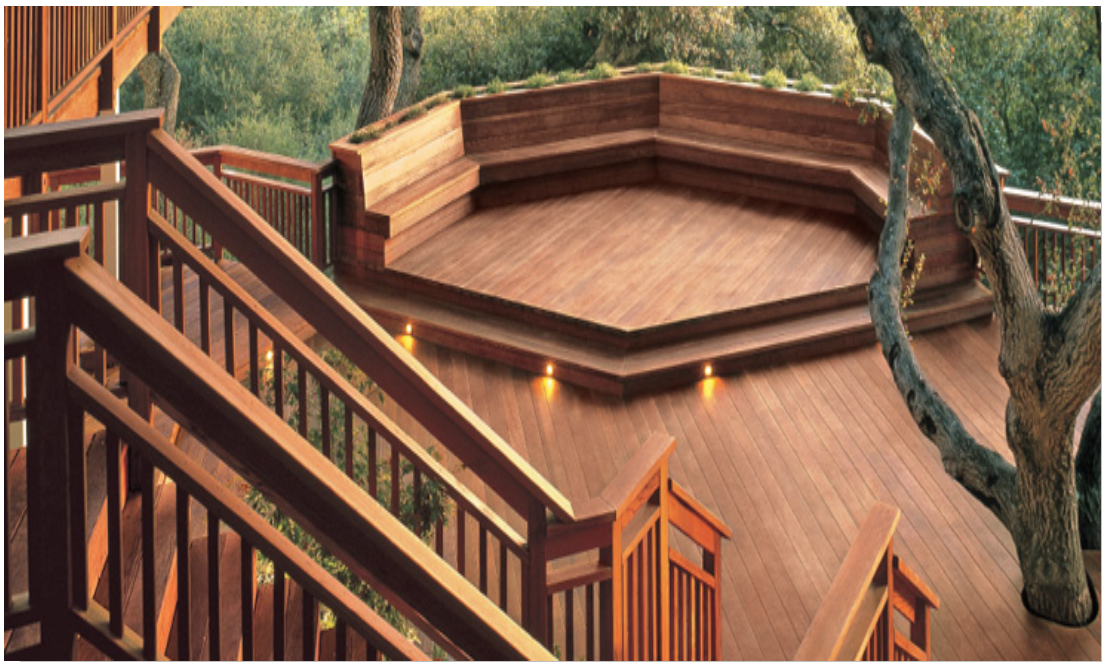
Εικόνα 3.43: Ολοκληρωμένο ξύλινο δάπεδο εξωτερικού χώρου.
