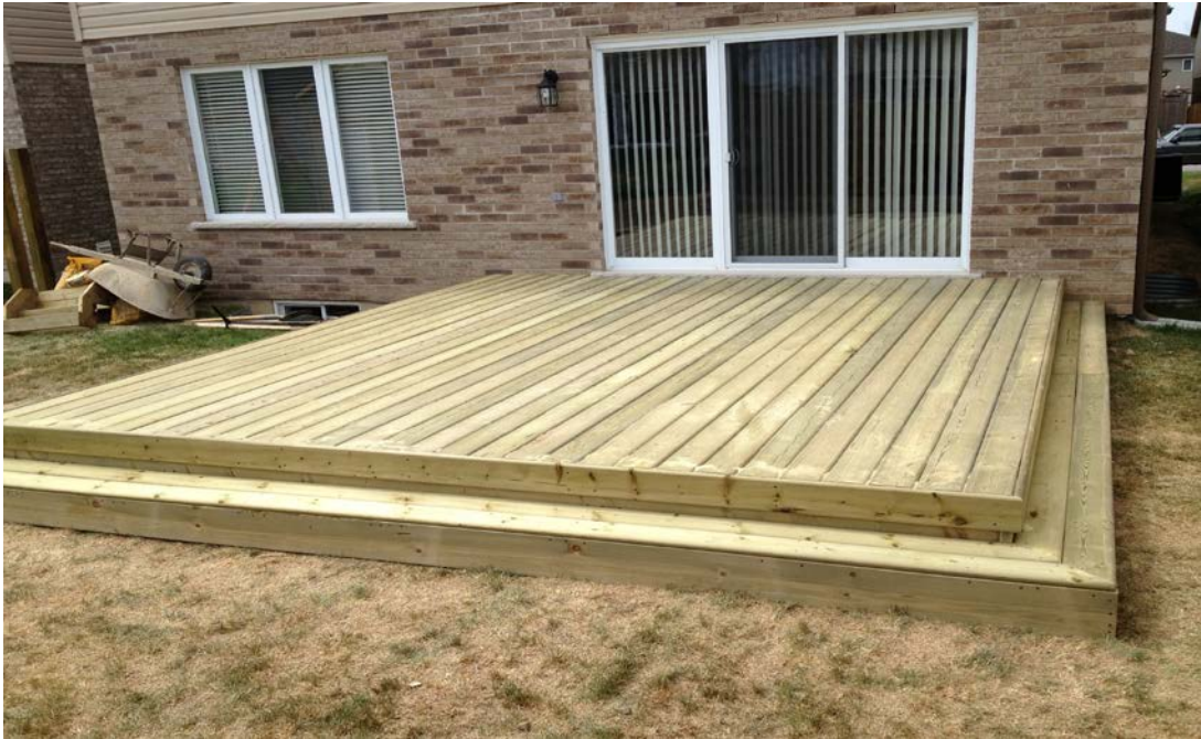
Εικόνα 3.42: Δημιουργία καλαίσθητου προφίλ υποκρύπτοντας το υπόστρωμα
