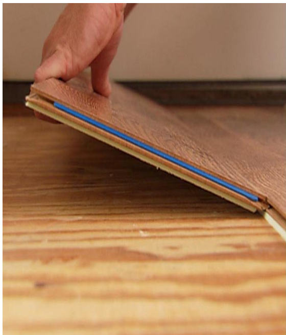
Εικόνα 3.44: Τοποθέτηση δαπέδου τύπου laminate
