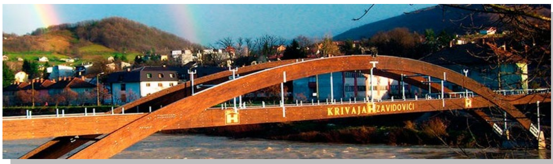
Εικόνα 2.10: Ξύλινη γέφυρα με επικολλητή ξυλεία
