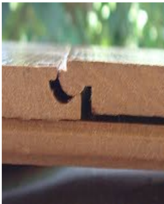
Εικόνα 3.45: Πρόοψη έτοιμου συνδέσμου βιομηχανικού δαπέδου
