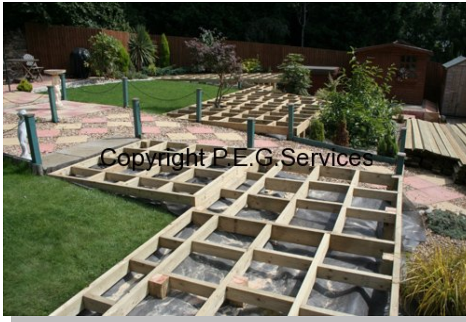
Εικόνα 3.39: Υπόστρωμα τοποθετημένο πάνω σε πασσάλους
