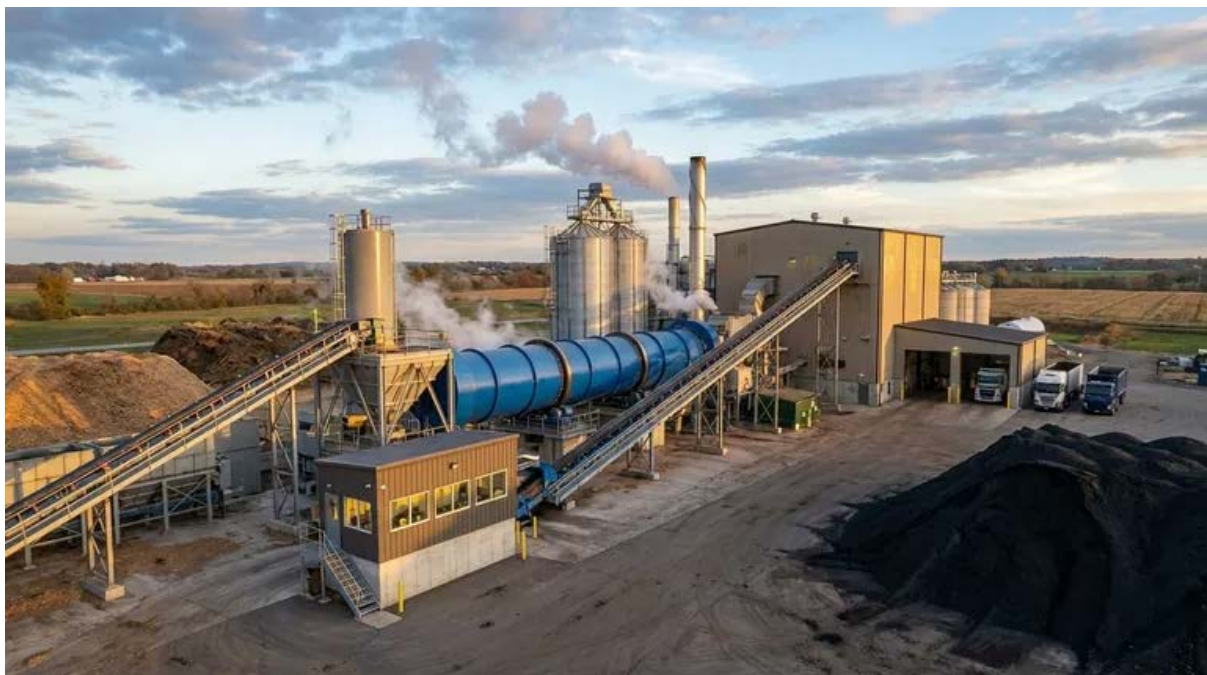
Εικόνα 6.23: Μεγάλης κλίμακας μονάδα παραγωγής βιοάνθρακα μέσω της διαδικασίας της πυρόλυσης.
