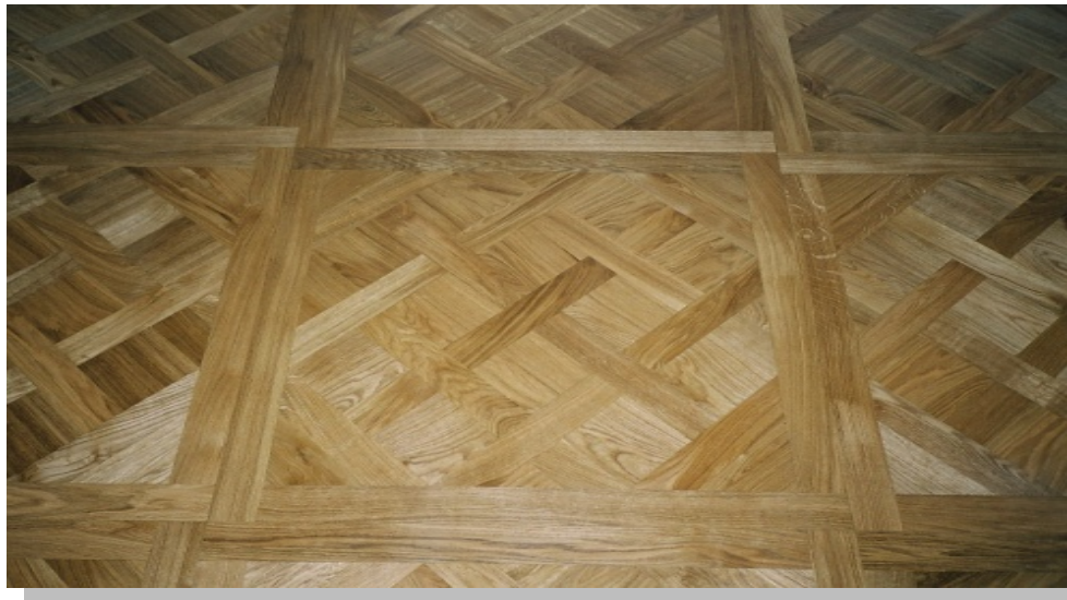
Εικόνα 3.15: Σχέδιο προκατασκευασμένου πλαισίου
