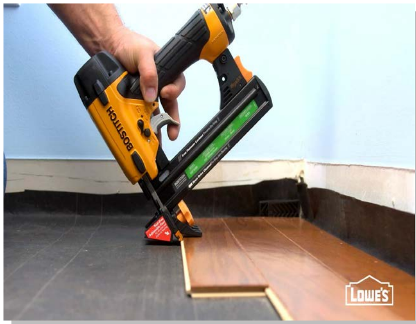
Εικόνα 4.16: Τοποθέτηση τρικολλητού δαπέδου με καρφωτικό μηχανήμα χειρός
