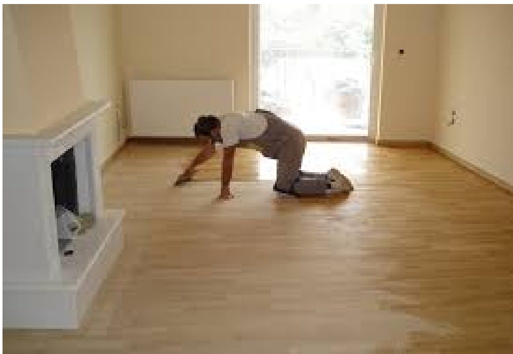
Εικόνα 4.23: Επίστρωση τρικολλητού δαπέδου με λάδι συντήρησης
